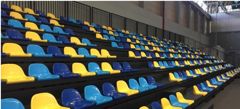
Vista de un módulo de la grada telescópica de Expourense
